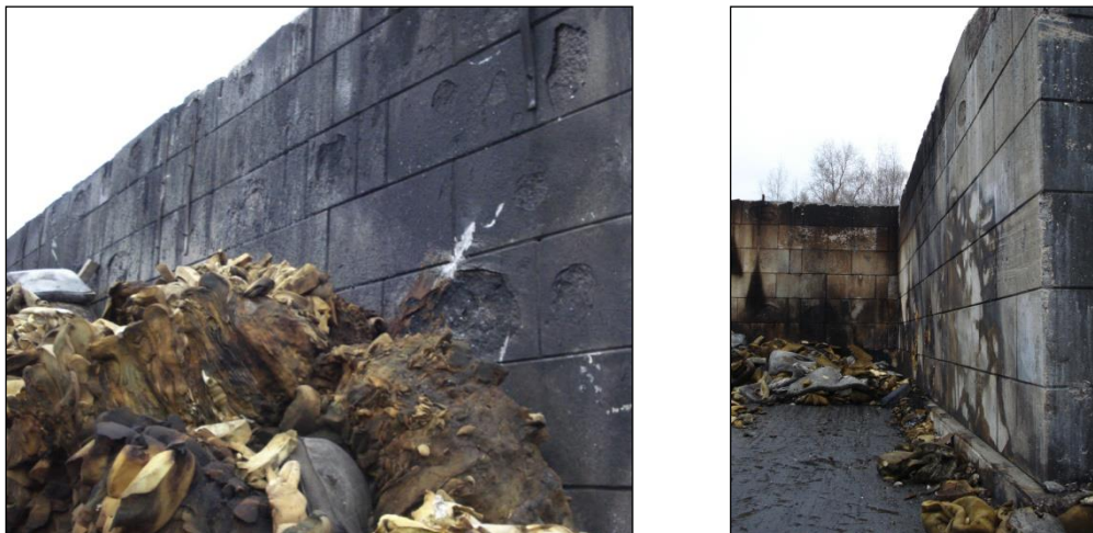
Figure 4: dommage d'écaillage
